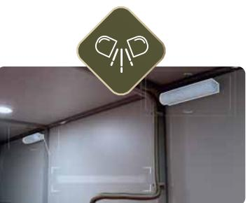
Оснащен саморазрывающимися капсулами (полностью испаряющимися через определённое время после срабатывания и не носящими вред оборудованию и людям)
