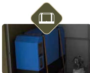
Основной и резервный генераторы имеют мощность от 15 до 35 кВт и способны обеспечить бесперебойным питанием весь комплекс.
